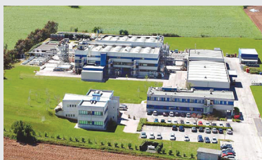
Chignolo d'Isola facility
